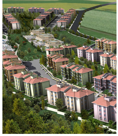
Armina Evleri 720 Daire - Bahçeşehir, İstanbul
